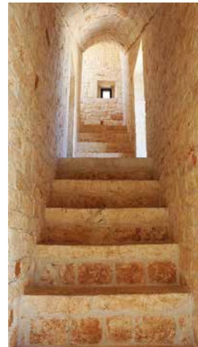
Il recupero della lamia ha comportato opere di manutenzione straordinaria con ripristino e pulizia delle murature perimetrali in pietra e la parziale redistribuzione degli spazi interni, adattandosi ai numerosi vincoli strutturali. L'ambiente vicino all'ingresso, riproporzionato da una volta a botte molto bassa, è stato conservato così com'era e arredato con panche in muratura: un salotto in nicchia minimale ma accogliente.
